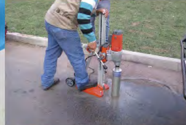
EXTRACCION DE DIAMANTINA EN ASFALTO
